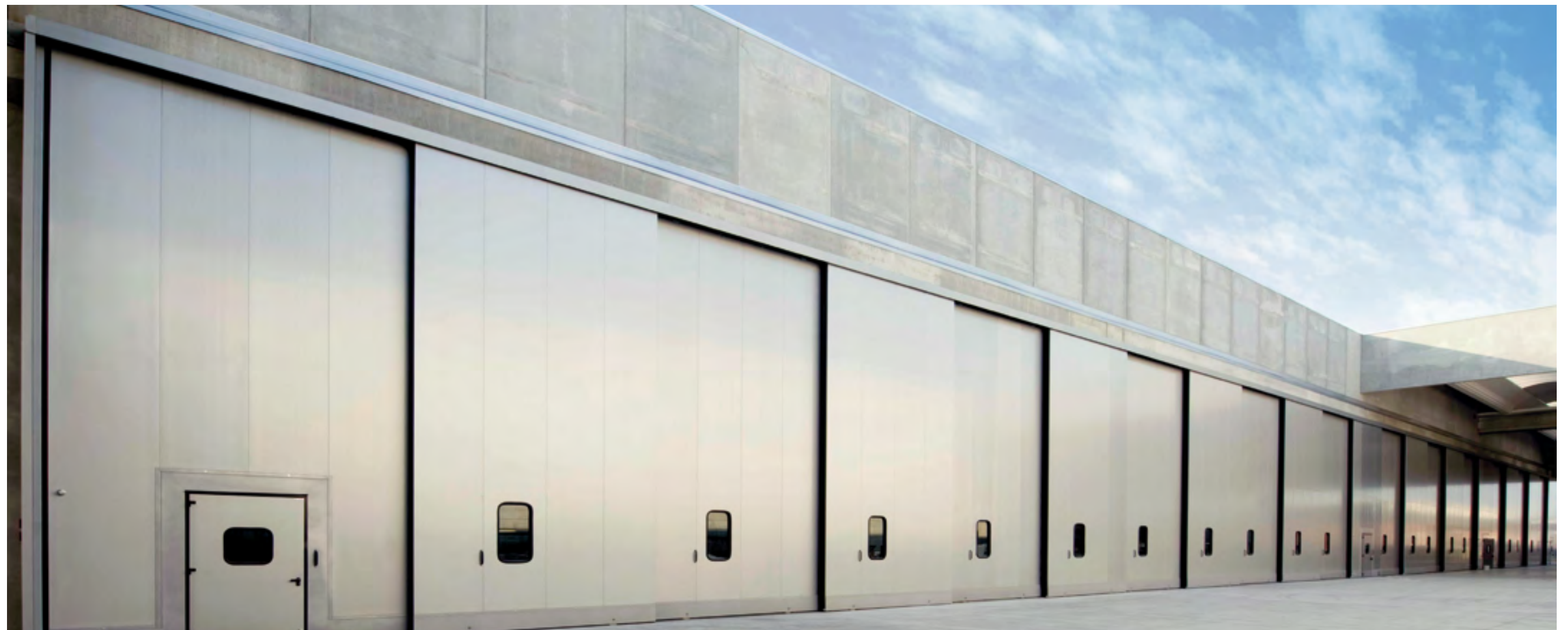
Cantiere Navale Piacenza - Italia Sliding - Portoni Scorrevoli Telescopici, manuali Dimensioni: L 105 mt. x H 8.5 mt.
