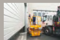
Montaggio e installazione Assembling and installation
