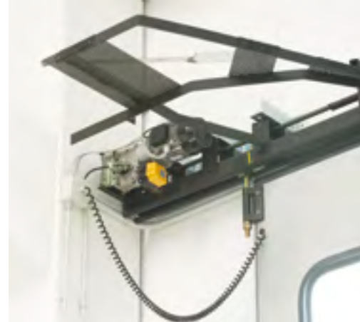
Raccoglitore con motore - Mod. Folding Motor of Folding door
