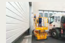
Montaggio e installazione Assembling and installation
